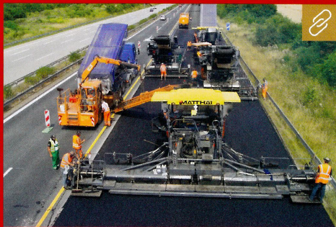
Mit Pave-IR von Moba wird während des Einbaus, hier mit einem Seitenbeschicker von Rumpel für den dritten Fertiger, ein flächendeckendes Thermalprofil der Asphaltoberfläche erfasst. Bild: Moba
